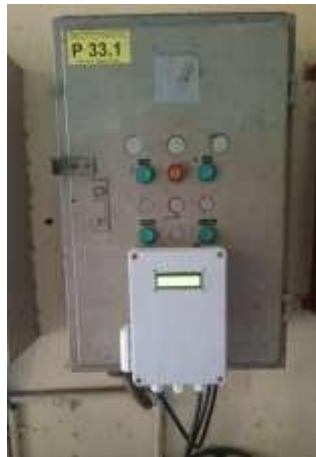
Gambar 6 Pemasangan Alat pada Panel kontrol Overhead Crane
