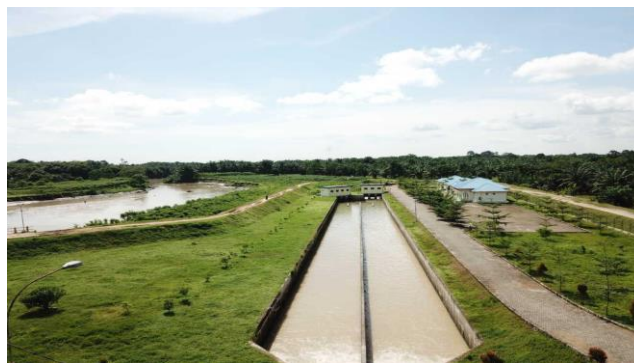
Gambar 4. Saluran intake primer menuju Desa Paya Pasir
