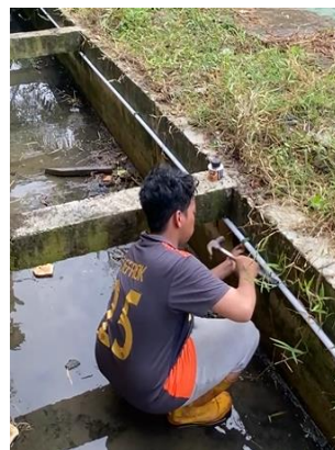
Gambar 13. Pembuatan Jalur Baru Sumber Air Hidroponik
