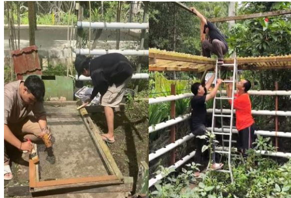
Gambar 12. Perbaikan Pintu dan Pengecatan Kayu
