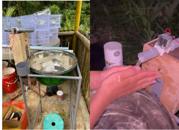
Gambar 9. Pemasangan dan Percobaan Wastafel
