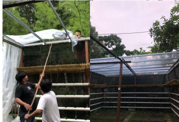
Gambar 14. Pemasangan Plastik UV
