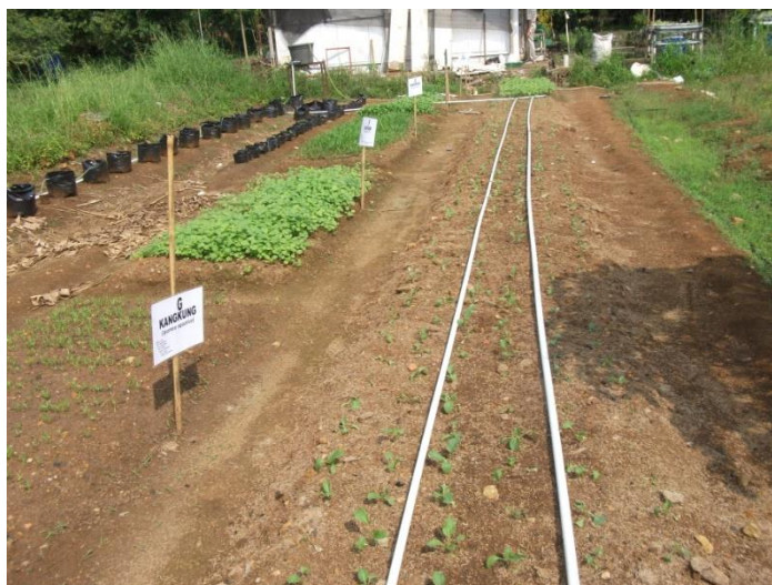
Gambar 3. Instalasi irigasi tetes yang sudah terpasang di lahan
