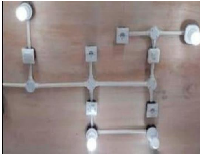
Gambar 4. Hasil Pembuatan Desain dan Instalasi Listrik Skala RumahTangga
